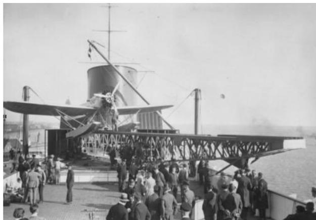
Fig.1 – Un idrovolante tipo Heinkel in fase di sistemazione sulla catapultata montata sul piroscafo Bremen
